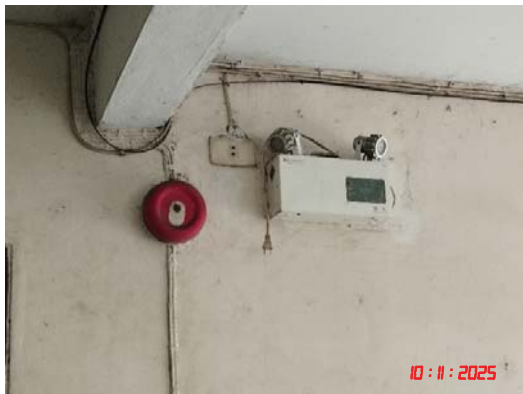
สัญญาณเตือนไฟไหม้และไฟฉุกเฉิน
